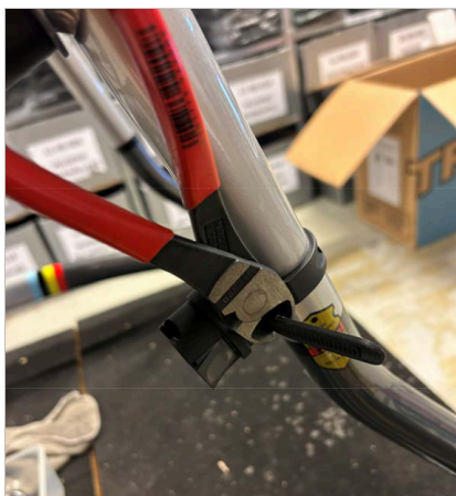
⑦ Reduzca el exceso del largo de la correa con un cortacables o cuchillo.
